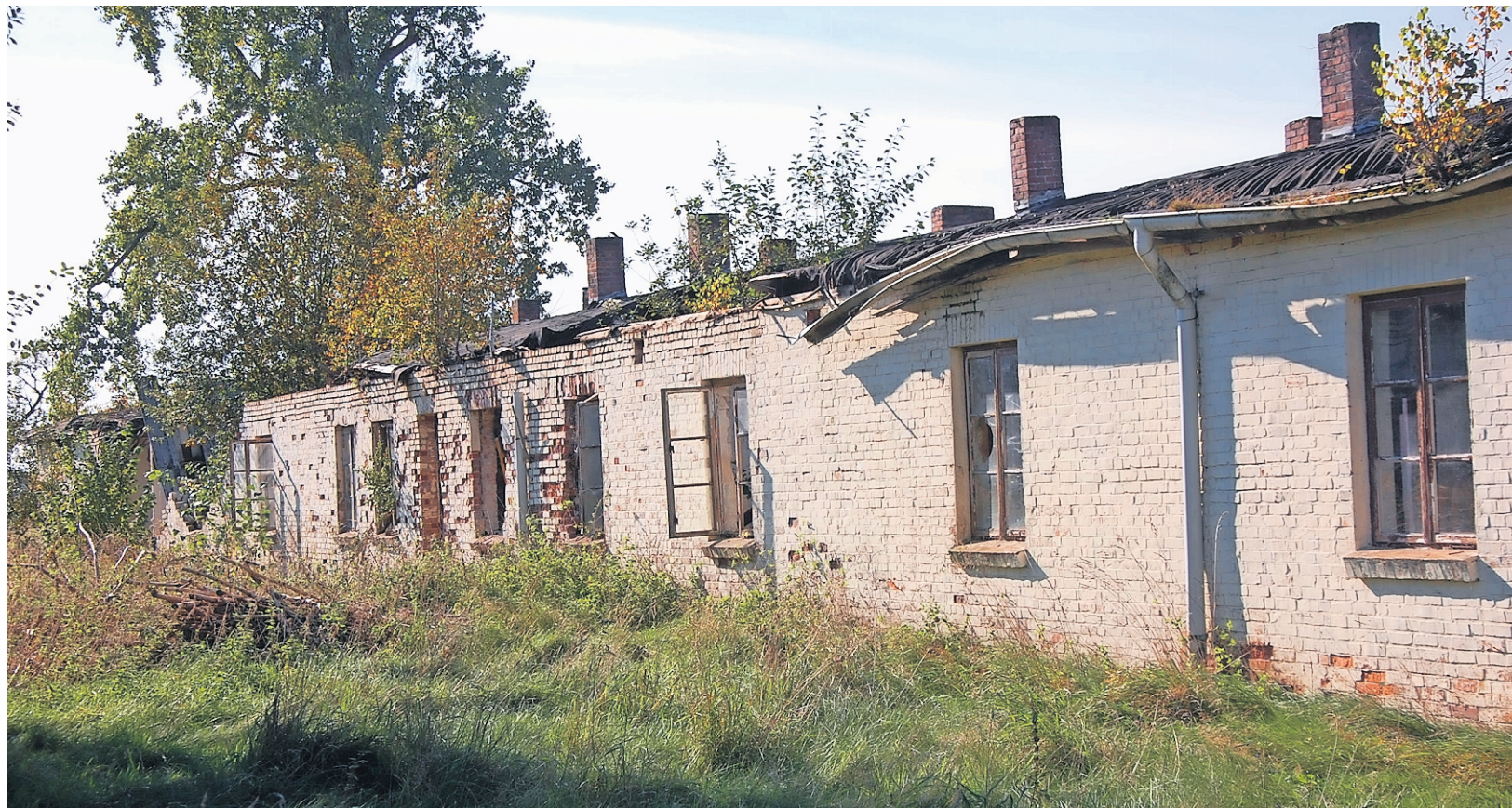
Verfallende Baracken bestimmen das Bild des Edelmannes-Grundstückes auf dem ehemaligen Lagergelände in Sandbostel . Die SPD/Grüne/WFB-Mehrheitsgruppe fordert jetzt in einem Antrag den Kauf des Geländes für 75000 Euro. Foto: Klöforn
